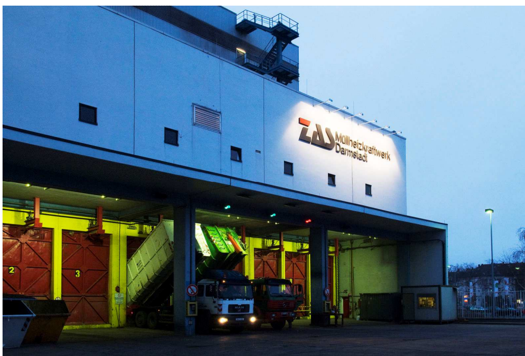
Abb. 10: Abfall-Anlieferung am Bunker des Müllheizkraftwerkes (Foto ZAS)
