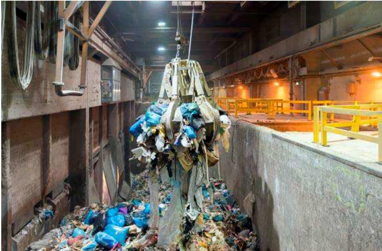
Abbildung 19: Restabfall aus dem Bunker wird mit Hilfe eines Greifers in den Brennofen gefüllt. Quelle: ZAW
